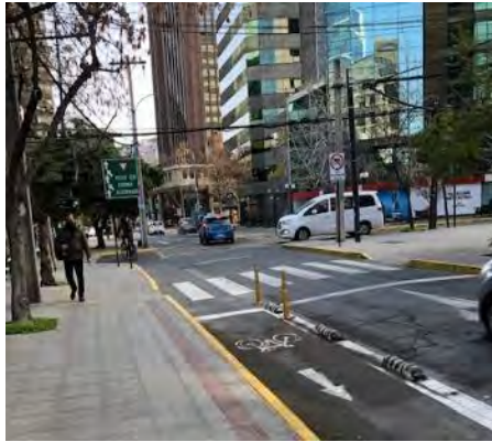
Entrada Ciclo vía Marchant Pereira
