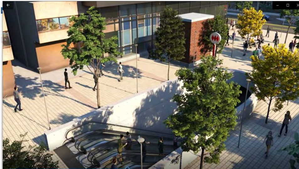
FIGURA N° 4.2-2: OBRAS INTERMODALIDAD CALLE SOTERO SANZ ESTACION PEDRO DE VALDIVIA LINEA 7
