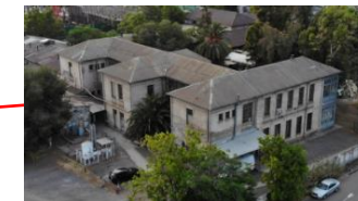
Pabellón A (bloque con forma de letra "H") ca. 1939
