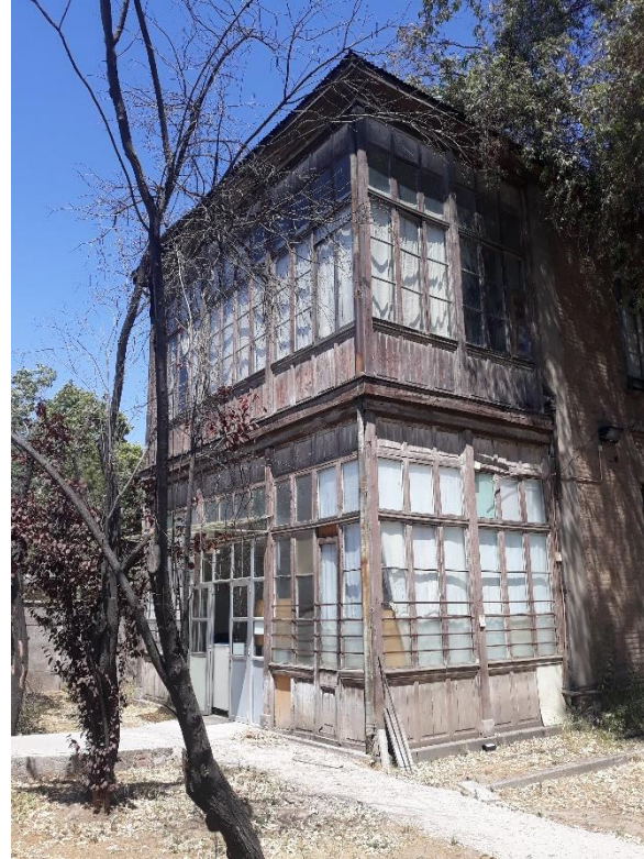
Solarium o veranda del volumen C, Pabellón Aguirre
