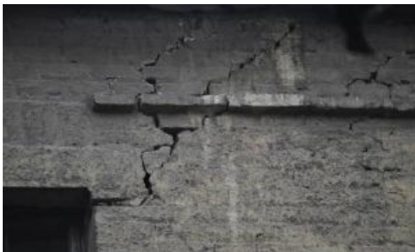
Reparación de fisuras nuevas, en muros, dinteles y encuentros
