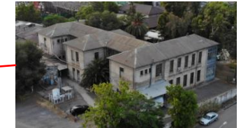
Pabellón A (bloque con forma de letra "H") ca. 1939
