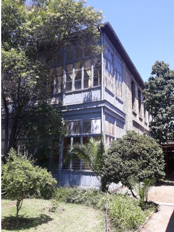
Solarium o veranda del volumen A, Pabellón Manuel Guzmán Montt
