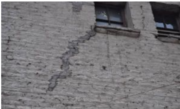
Reparación de fisuras ya tratadas anteriormente (se reprodujeron adyacentes al nuevo hormigón)
